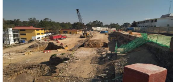
Perforaciones para cimentación
