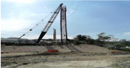
Izaje de pilas para levantamiento de la estación
